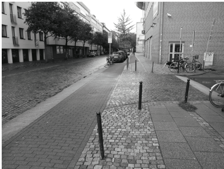
Abb. 9 Radwegüberfahrt über eine Einmündung in Bremen
