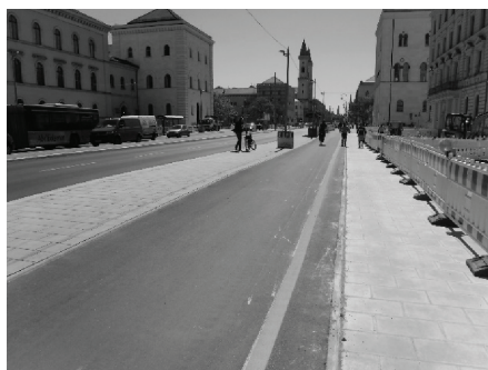
2. Einrichtungs-Radweg mit 2,90 m über Regelbreite (München)
