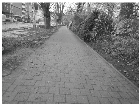
1. Zweirichtungsweg übersteigt Regelbreite mit 3,5m (Kiel)
