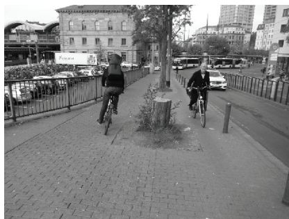
3. Radweg im Zweirichtungsbetrieb (einseitig) mit 1,6 m weit unter Mindestbreite (2 m); zusätzlich extreme Engstellen durch Bäume (Restbreite 0,7 m. Mainz)
