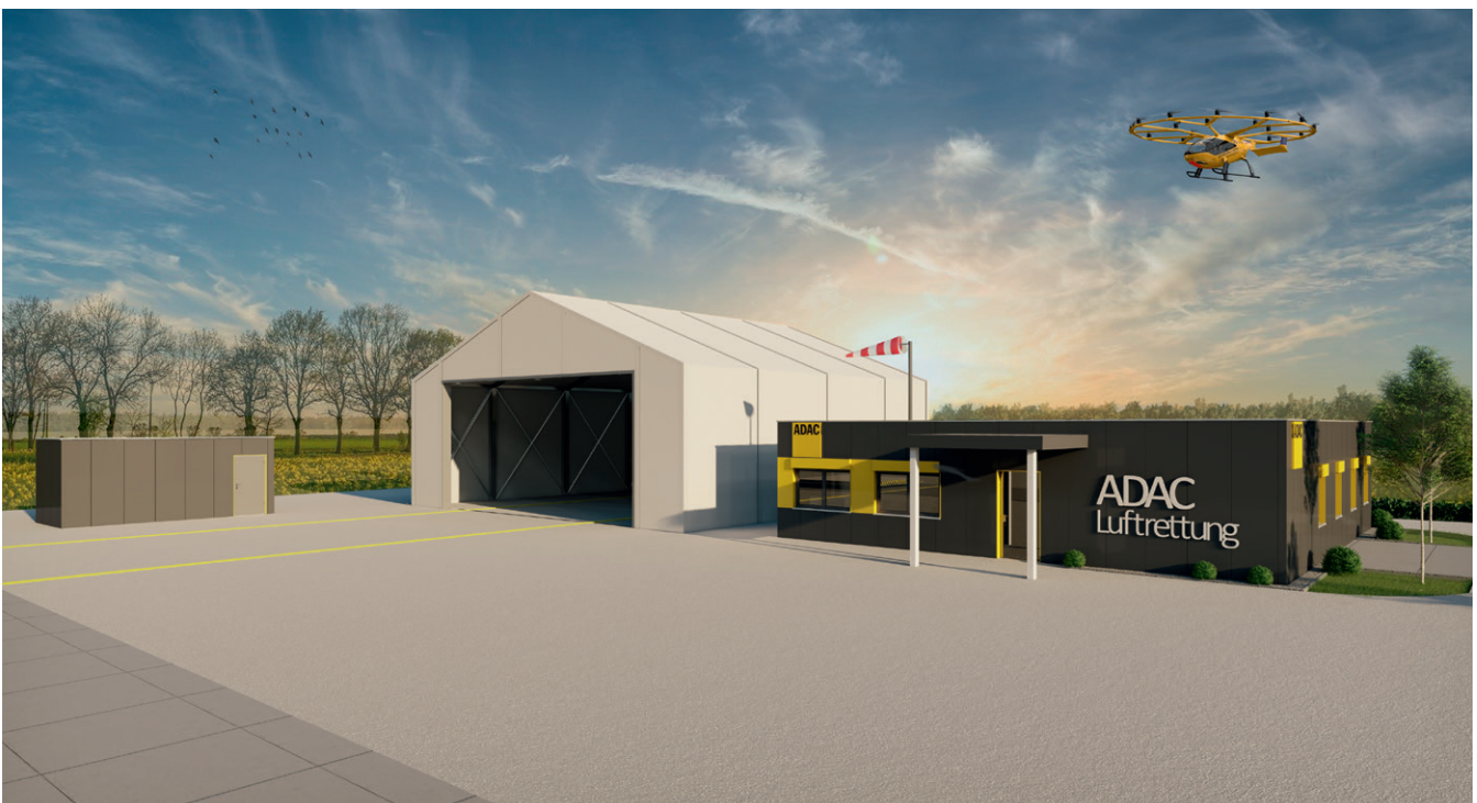
Abbildung 9.1: Containerstation mit Leichtbauhangar
